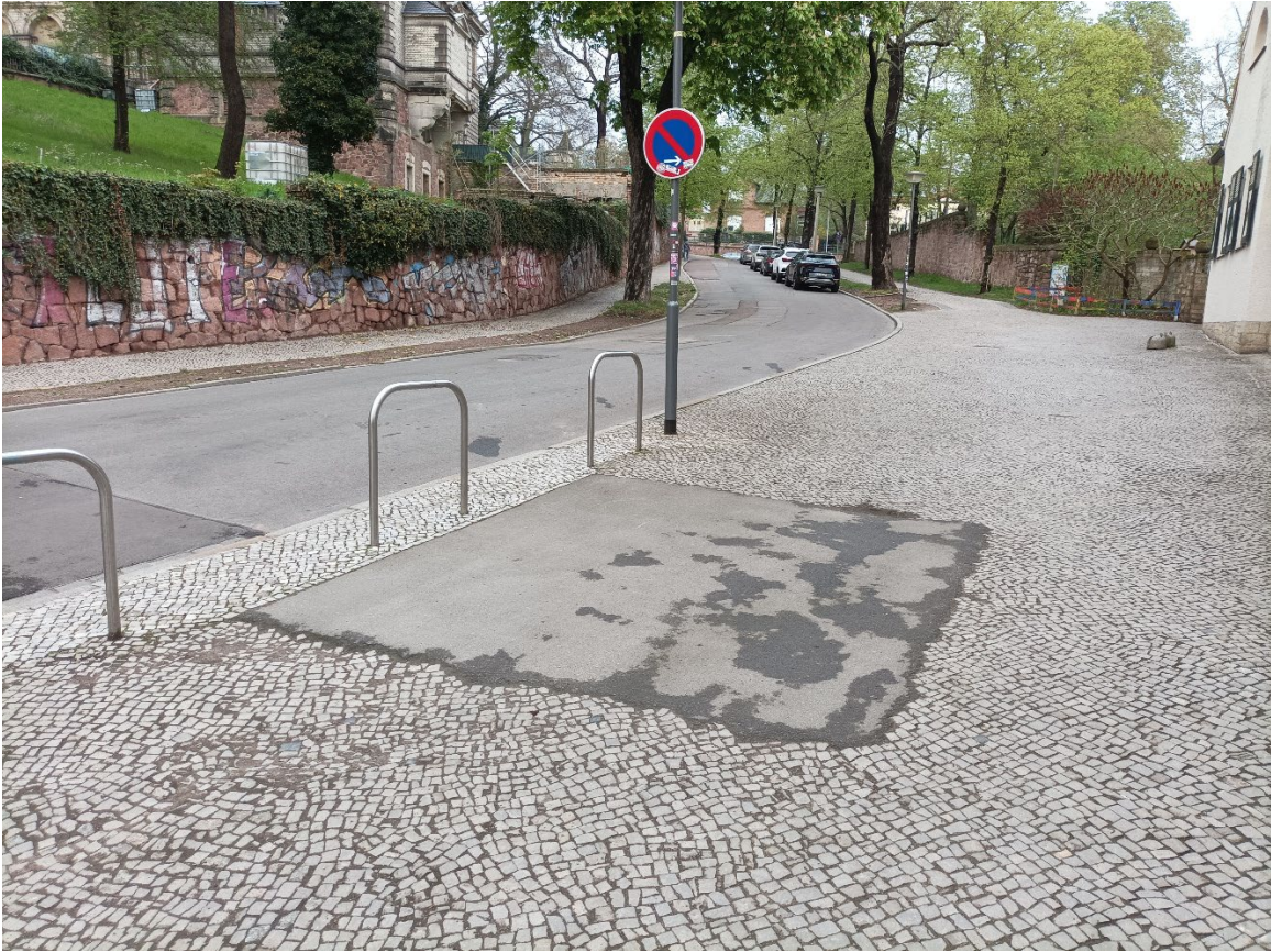
02-Halle-Giebichenstein-Riveufer - Höhe Integrative Kindertagesstätte - Blick nach Nordosten auf Ex-Baumstandort in Richtung Burgstraße
