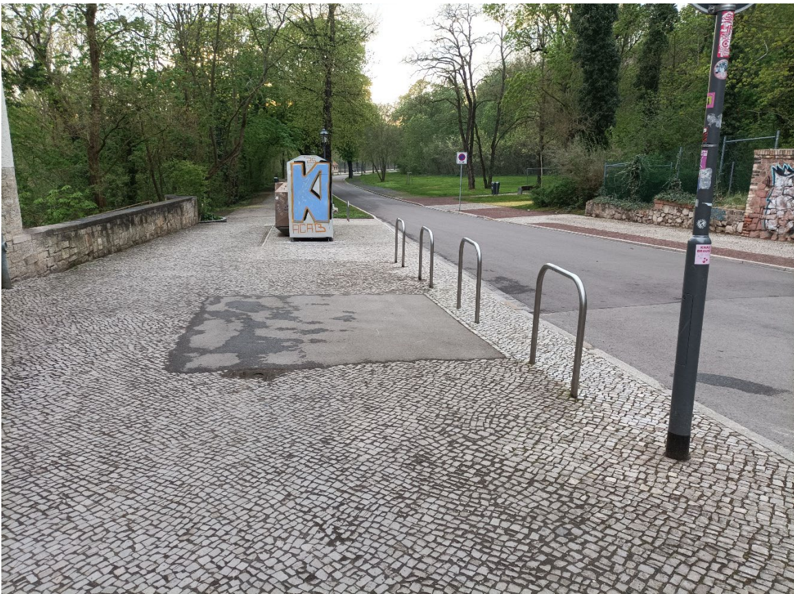
03-Halle-Giebichenstein-Riveufer - Höhe Integrative Kindertagesstätte - Blick nach Nordwesten auf Ex-Baumstandort in Richtung Saale
