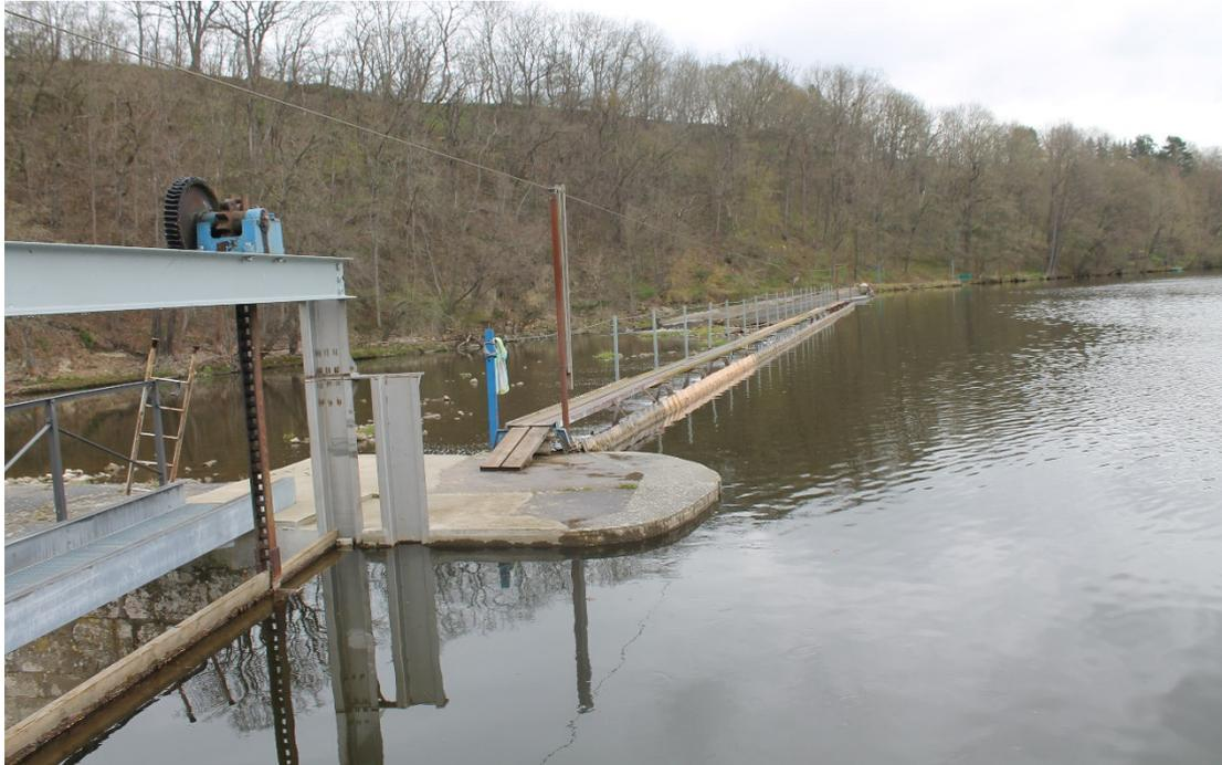
**Bild 01** Ansicht Saalewehr mit Floßgasse bei Aufstau , oberwasserseitig
