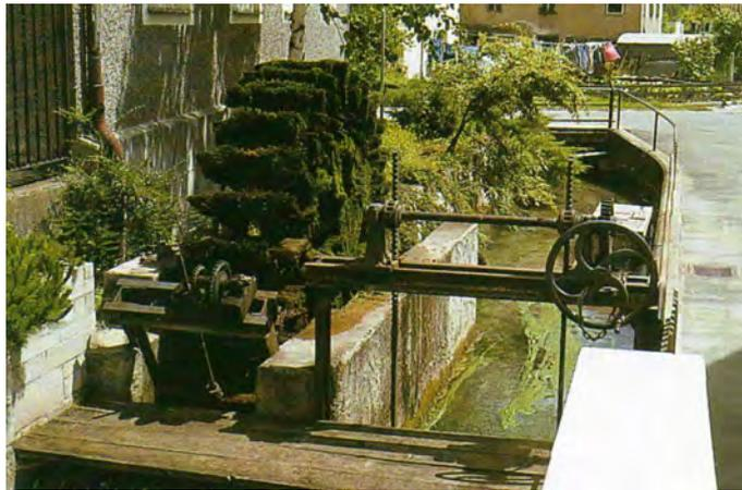
Abb. 1 – Unterschlächtiges Wasserrad an einem Mühlgraben (Hutter Konold Schreiner (1996). S.111)
