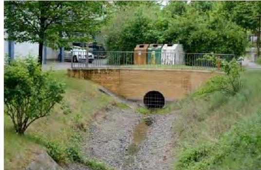
Abb. 19 – Übergang in Verrohrung unter BfA
