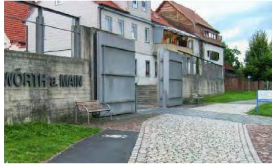
Abb. 9 – Hochwasserschutzmauer in der Altstadt Würth am Main (Prominski, Stokman, Stimberg (2012). S.180)
