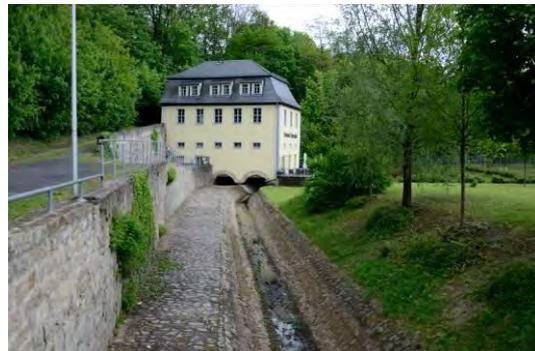
Abb. 16 – Befestigte Sohle Bereich Wasserkunst
