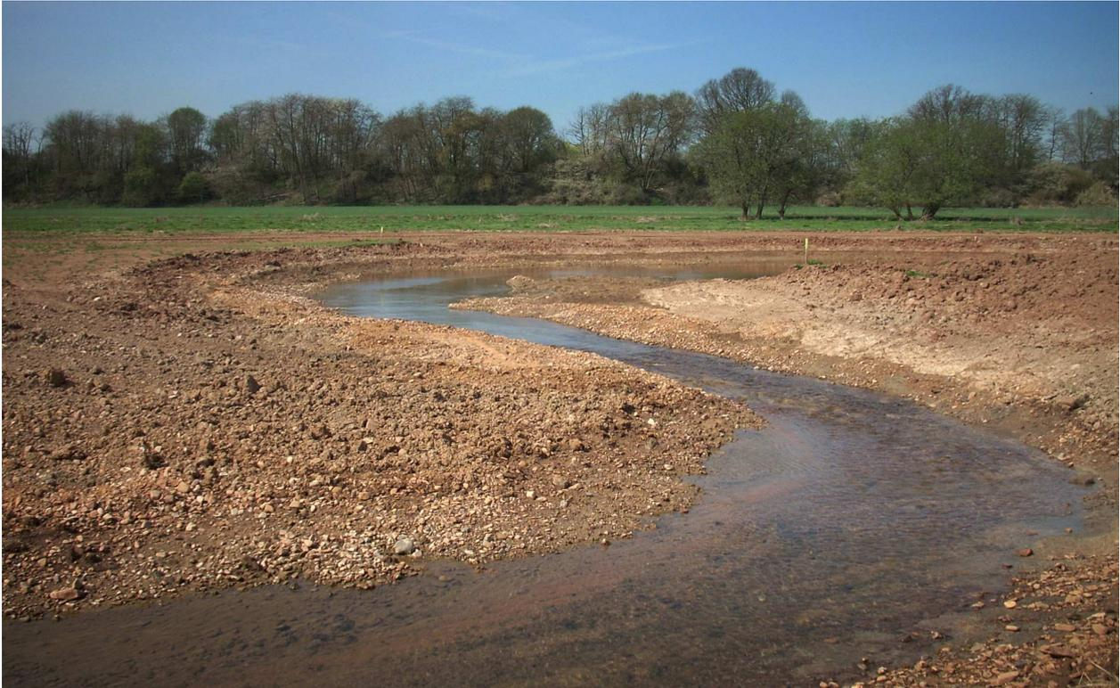
**Abbildung 17:** Die im Winter 2010/2011 realisierte Umgestaltung des Unterlaufes der Wohra bei Kirchhain aus einem geradlinigen, monotonen Gerinne in einen flachen, gewunden Bachlauf innerhalb eines abgesenkten Auenstreifens ist mit der geplanten „Wildflusslandschaft“ vergleichbar; die Aufnahme entstand unmittelbar nach Abschluss der Erdarbeiten.
