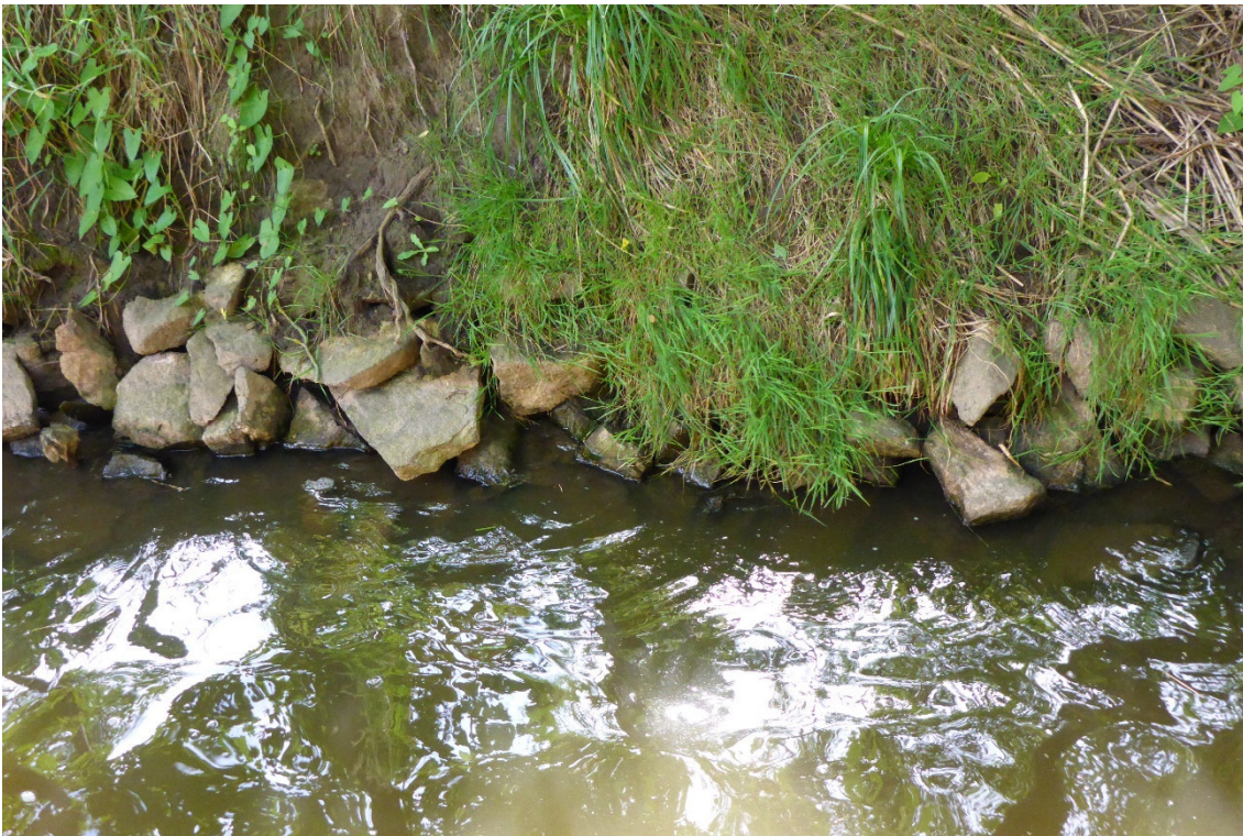
Steinschüttungen im Uferbereich
