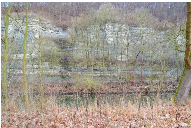
Abbildung 15: Ufersicherung rechtsseitig der Werra im Bereich des Zufahrtsweges von Falken zur Probsteizella (Fluss-km 087+981)
