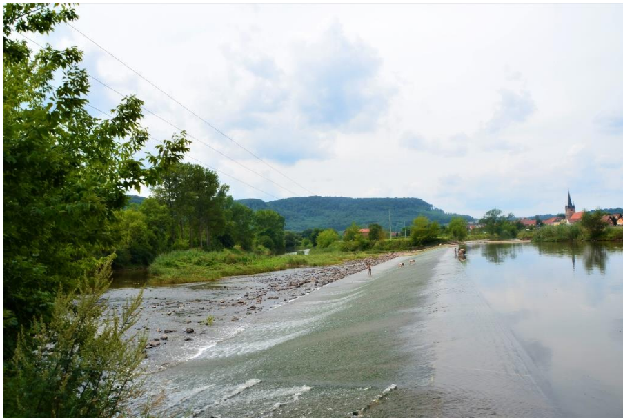
Abbildung 16: Das Streichwehr in Falken mit Staustufe
