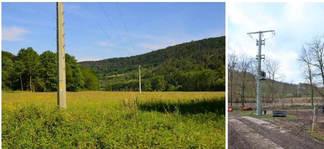
Abbildung 33: Fotos der Stromtrasse und der vorhandenen Masten (links: Baufeld Erdabtrag, rechts: Mast jenseits der Werra)
