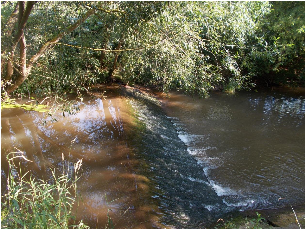
Abbildung 2: Ansicht des Sohlabsturzes von rechts
