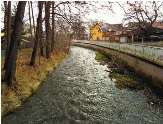
Oberhalb Brücke Bahnhofstraße, Blick in Richtung Unterwasser
