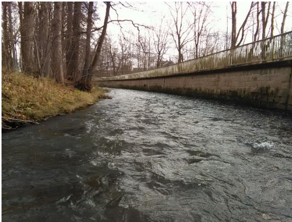
Blick in Richtung Unterwasser
