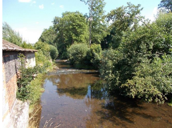
Absturz vom Oberwasser aus
