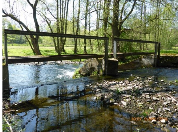
Wehr Grenzhammer vom Oberwasser aus
