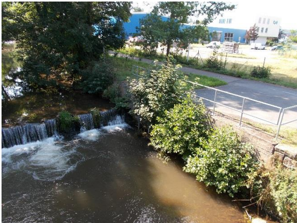
Wehr mit Ufermauer rechts vom Unterwasser
