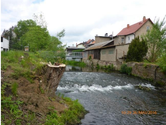
Absturz vom Unterwasser aus
