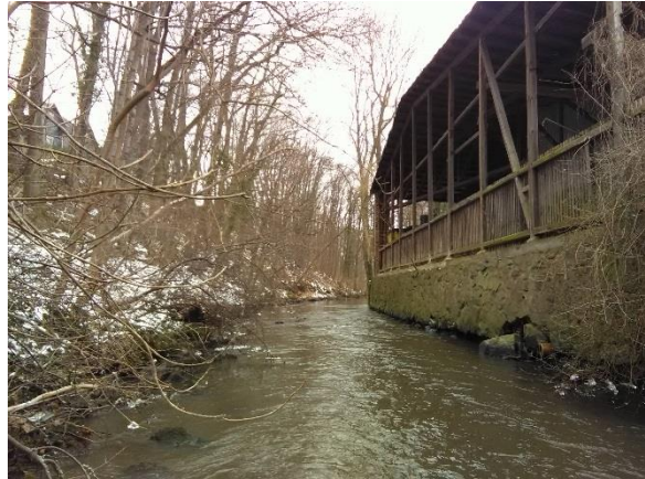
Blick in Richtung Unterwasser
