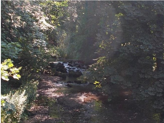
Blick auf die Sohlenrampe Langewiesen vom Unterwasser aus
