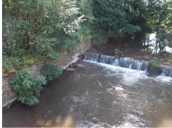
Wehr mit Ufermauer links vom Unterwasser
