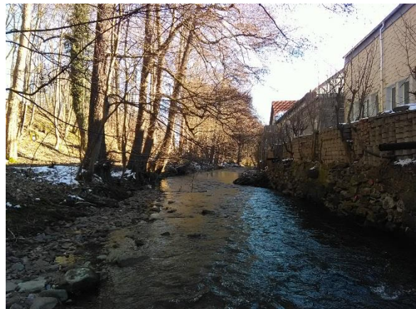
Blick in Richtung Unterwasser
