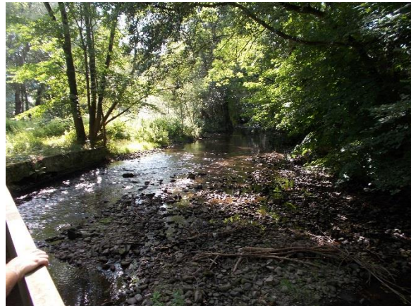
Blick vom Wehr in Richtung Oberwasser
