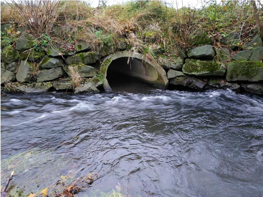
Abbildung 7: Einlauf Betonrohr DN1600 unterhalb der Radwegebrücke
