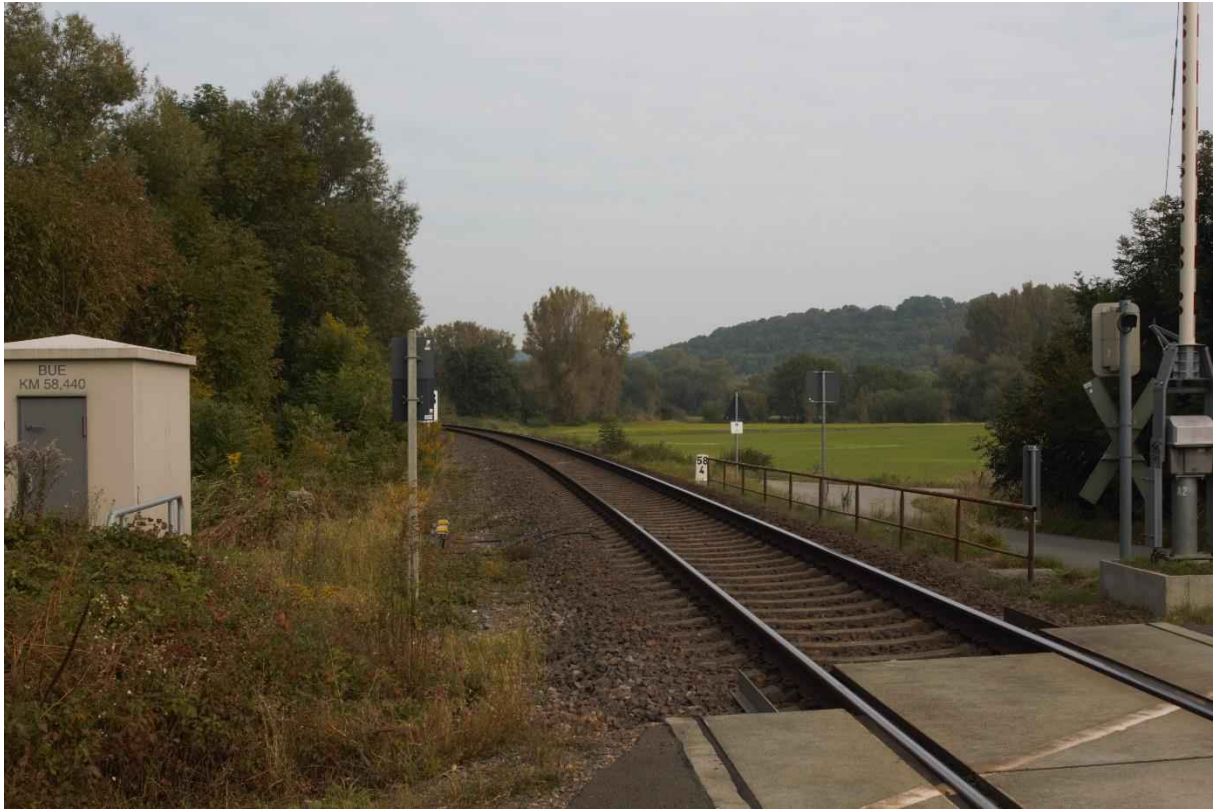
Abbildung 23: Bahnstrecke im Bereich des Bahnübergangs
