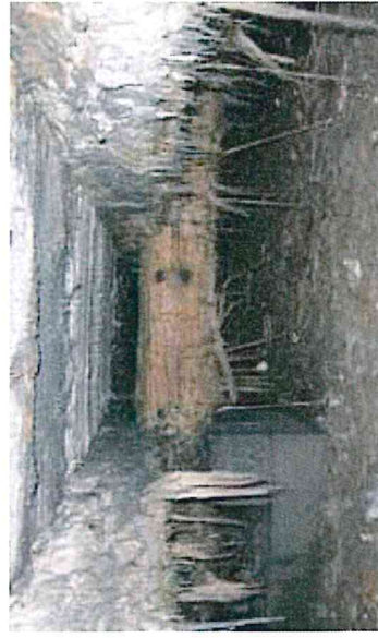
Sanierungsbedürftige Fußpunkte am Querstück
