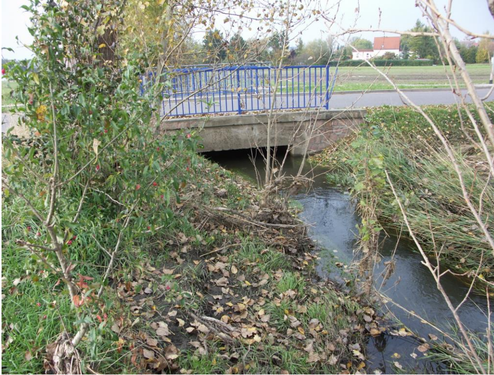
Bild 1: Straßenunterführung zwischen und Kleinkugel und Naundorf, die zum Hochwasserzeitpunkt als Wasserstauer wirkte.
