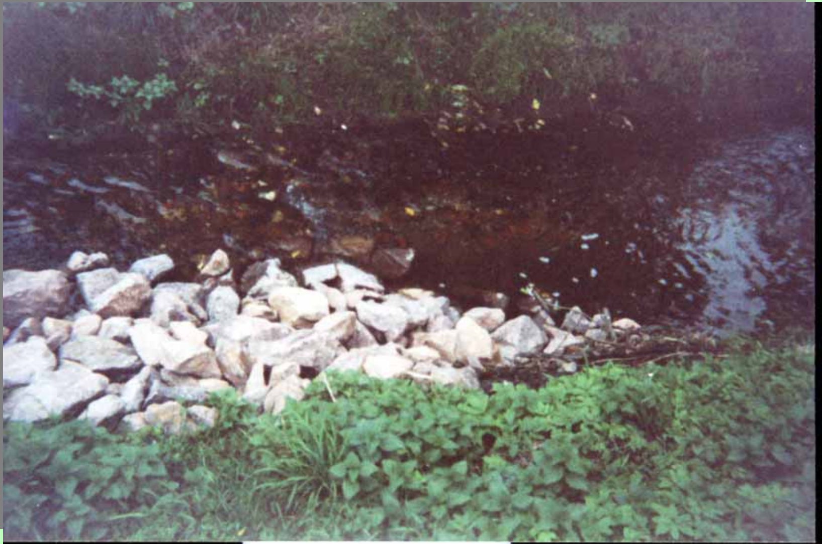
neu eingebaute Steinbühnen
